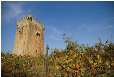
Torre de Quintela
