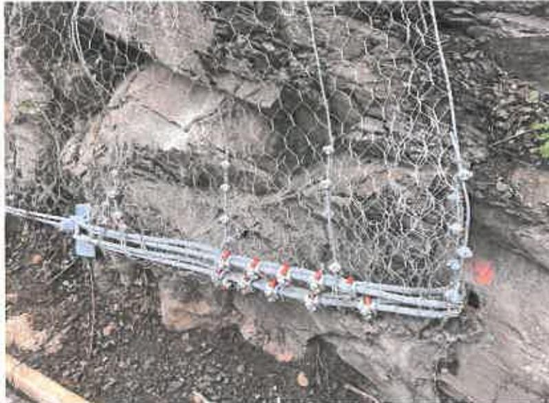
**Fotografia 17 – Exemplo de cerra-cabos para aplicados em cabo de aço de ancoragem na base de rede metálica de tripla torção.**
