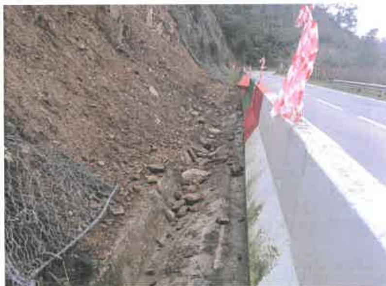
**Fotografia 7 – Vista geral da valeta de plataforma – de seção triangular assimétrica revestida – da EM 313 no local do escorregamento do talude de escavação (Geovia, 23 de dezembro de 2022)**
