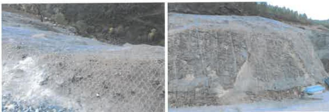
**Figura 14 – Exemplo de aplicação de rede metálica de tripla torção: vista de topo (esquerda); rede metálica desenrolada ao longo do talude (direita)**
