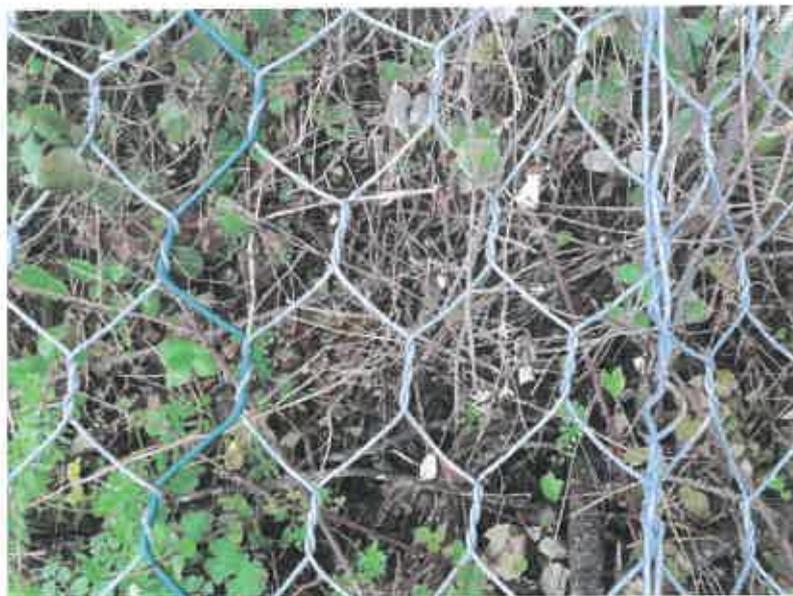
**Fotografia 13 – Pormenor da união entre painéis adjacentes da rede metálica de malha hexagonal (Geovia, 23 de dezembro de 2022)**
