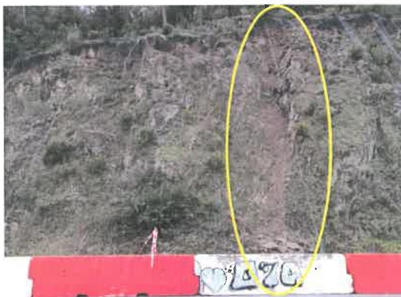
**Fotografia 8 – Escorregamento em cunha ocorrido em toda a altura do talude de escavação, com deposição do material escorregado na base (Geovia, 23 de dezembro de 2022)**
