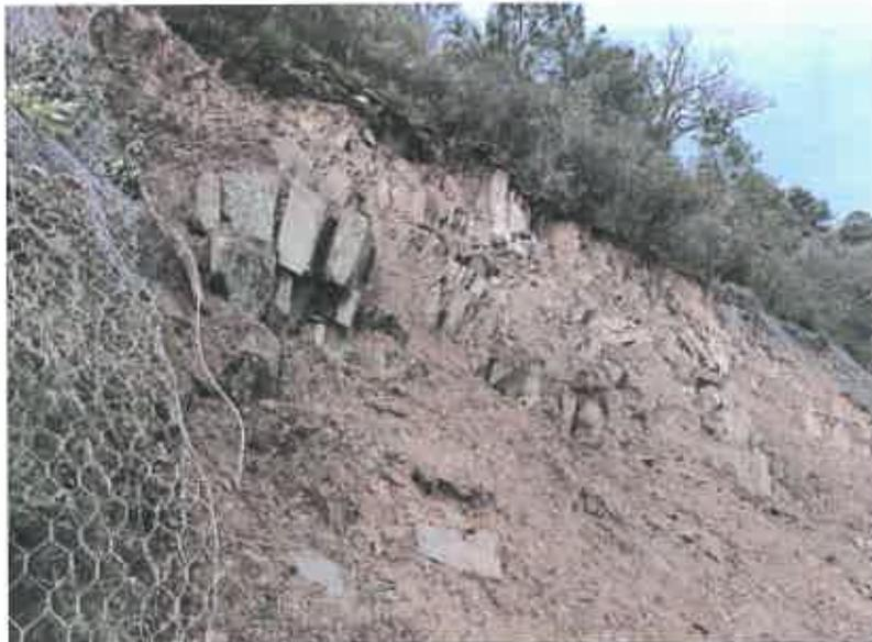
**Fotografia 4 – Pormenor de blocos rochosos soltos na área de escorregamento do talude de escavação (Geovia, 23 de dezembro de 2022)**
