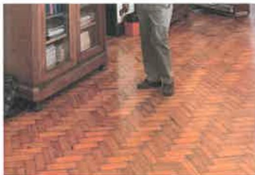
Figura 57. Pavimento em taco de madeira
