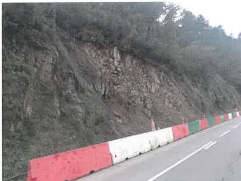
**Fotografia 2 – Vista geral da área de escorregamento do talude de escavação que afetou toda a altura do talude (Geovia, 23 de dezembro de 2022)**
