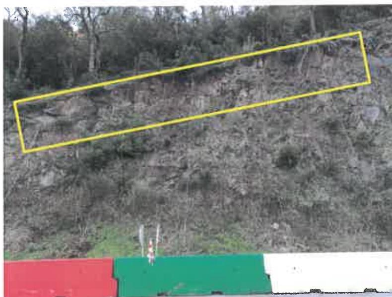
**Fotografia 10 – Presença de material rochoso descomprimido no topo do talude de escavação (Geovia, 23 de dezembro de 2022)**
