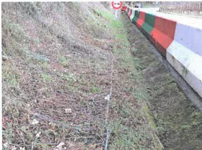
**Fotografia 11 – Pormenor da base da rede metálica instalada e da largura da banquetta de visibilidade do talude de escavação (Geovia, 23 de dezembro de 2022)**
