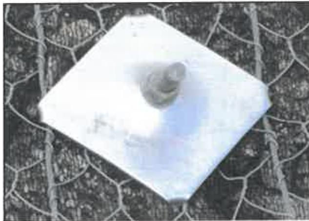
**Figura 21 – Placa de pregagem sobre rede de tripla torção**
