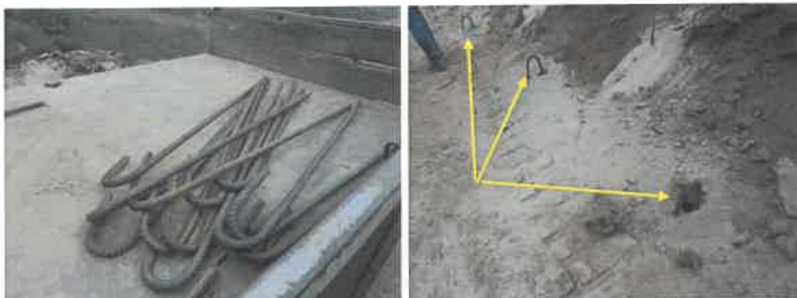
**Figura 13 – Bengalas (varões de aço) de fixação da rede metálica ao talude**
