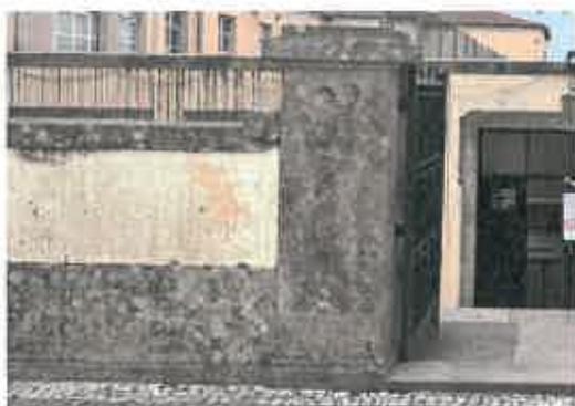
Figura 47. Embasamento e capeamento do muro em granito
