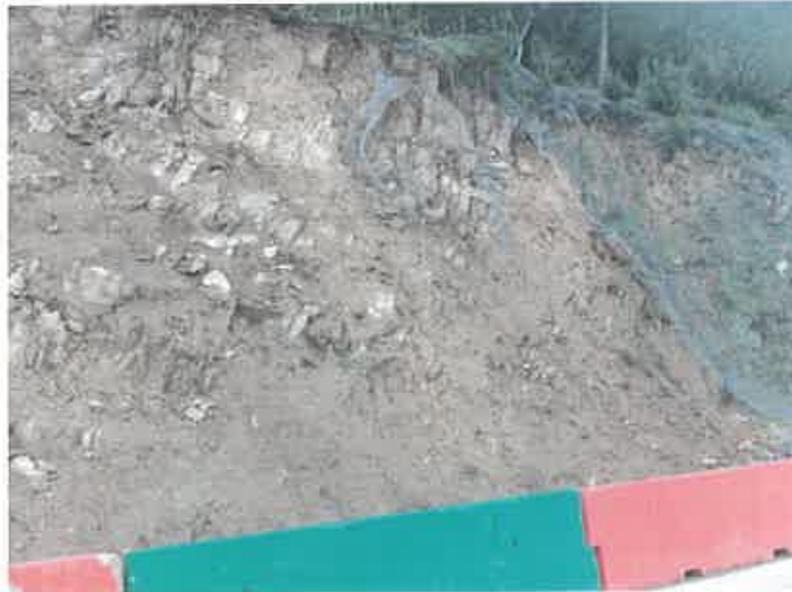
**Fotografia 5 – Pormenor do dano na rede metálica resultante do escorregamento ocorrido no talude de escavação (Geovia, 23 de dezembro de 2022)**
