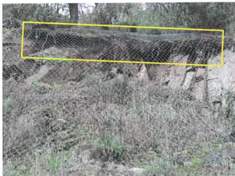
**Fotografia 14 – Detalhe da formação de “consola” no topo do talude de escavação (Geovia, 23 de dezembro de 2022)**
