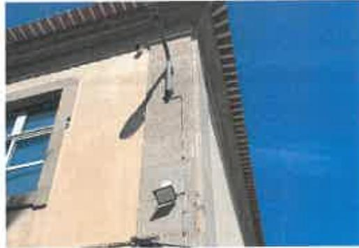
Figura 50. Pilastra e cornija em pedra de granito
