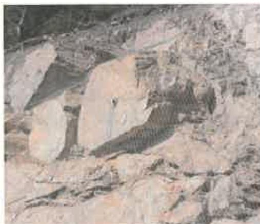
**Figura 23 – Exemplo de aplicação de pregagem pontual em bloco rochoso em rotura por cunha**
