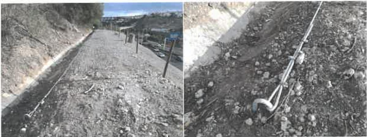
**Figura 17 – Exemplo de cerra-cabos para aplicados em cabo de aço de ancoragem no topo de rede metálica de tripla torção**
