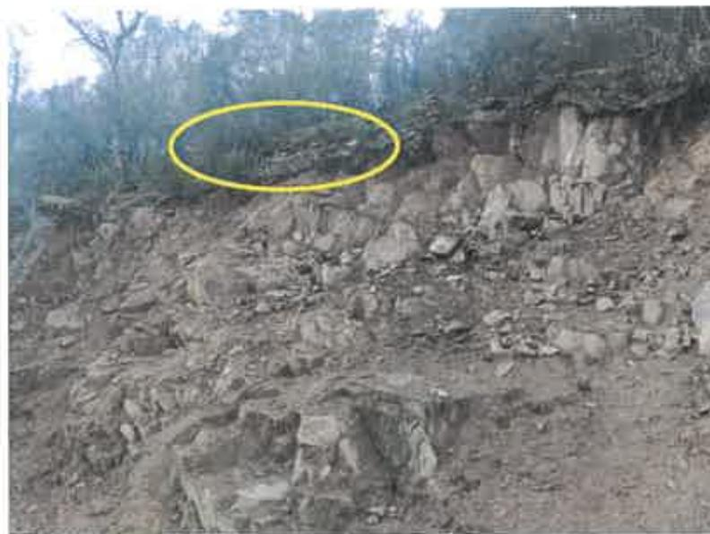
**Fotografia 6 – Presença de muro de pedra arrumada à mão situado na crista do talude de escavação na zona do escorregamento (Geovia, 23 de dezembro de 2022)**
