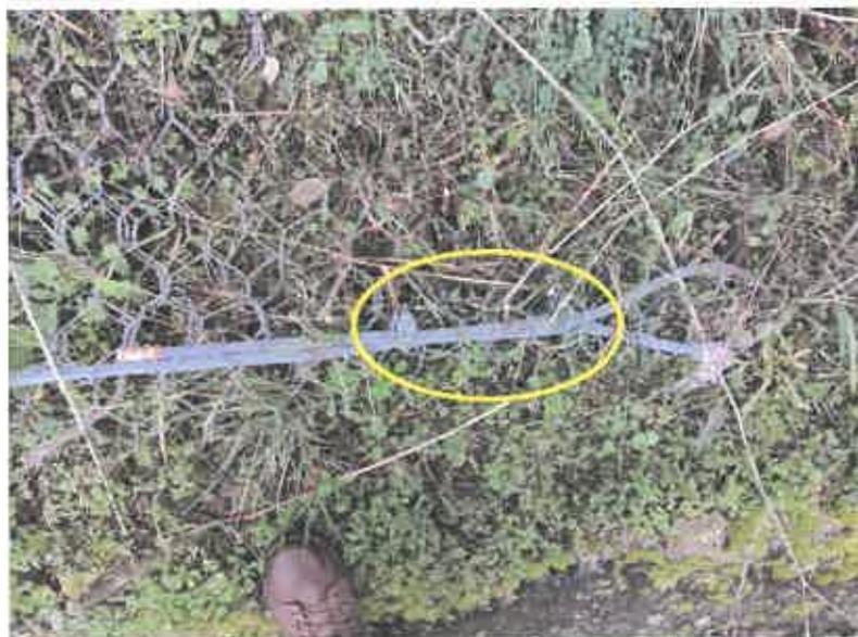
**Fotografia 12 – Pormenor dos dois cerra-cabos na extremidade do cabo de aço na base da rede metálica (Geovia, 23 de dezembro de 2022)**
