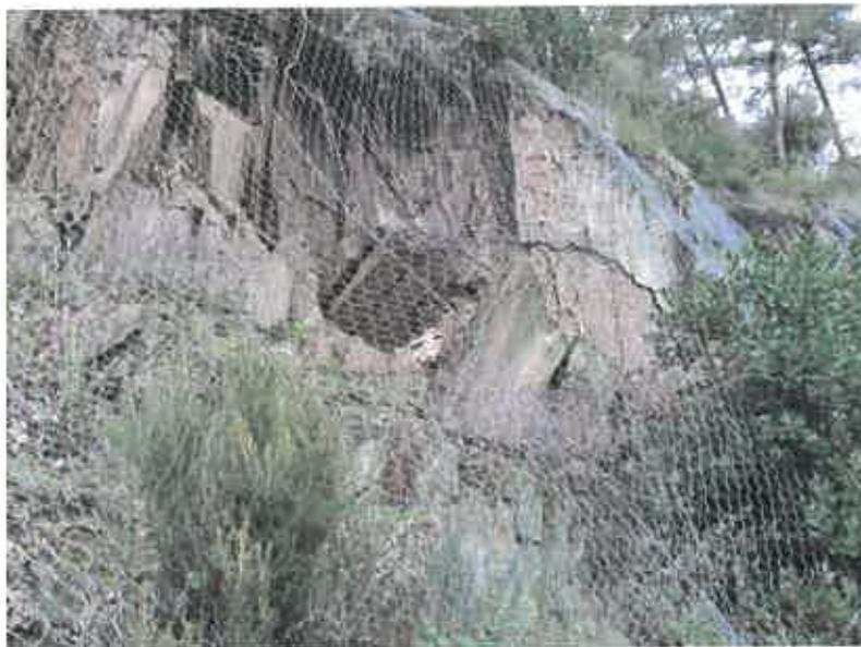
**Fotografia 9 – Pormenor de blocos rochosos descomprimidos/soltos no topo do talude de escavação (Geovia, 23 de dezembro de 2022)**
