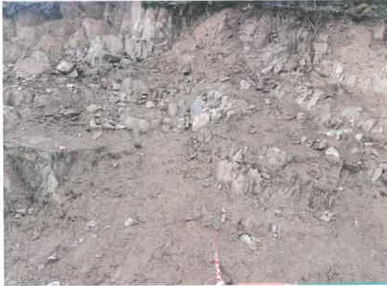
**Fotografia 3 – Idem, com pormenor de material rochoso envolvido no escorregamento com material de granulometria no âmbito dos solos (Geovia, 23 de dezembro de 2022)**
