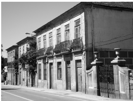
Casas de Vila Nova da Fé, actualmente em recuperação — actual Rua Madame Brouillard (foto do autor, 2010)
